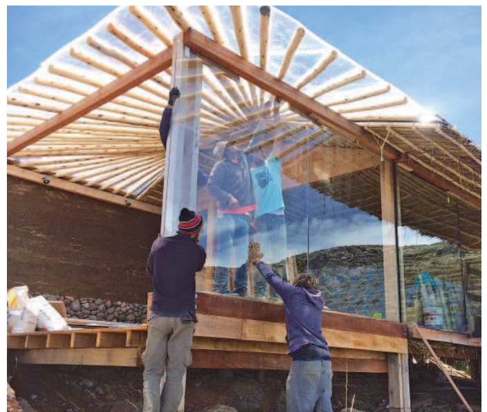
Amantica Lodge se crea a partir de una estructura de madera que se sostiene en pilotes anclados en el terreno. El piso se compone de totora, aserrín y cal, cerrándose con tablones de madera. El muro orientado al norte se compone de adobe. La terraza se protege del exterior a través de un vidrio templado y un techo de policarbonato. El techo de una estructura está forrado con un mix de totora, caucho reciclado y totora. El cerramiento final de totora se repite en los otros espacios como el baño, la cocina y el depósito.
