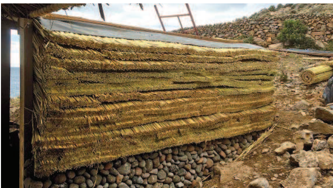
El baño está rodeado de un muro de 60 cm de espesor, construido con una técnica constructiva aymara. Por el otro lado, un muro se compone por rocas apiladas cuidadosamente. En otra de las paredes se colocaron capas de totora que impermeabilizan el espacio. La cocina se construyó a partir de los vidrios colocados en la habitación principal.
