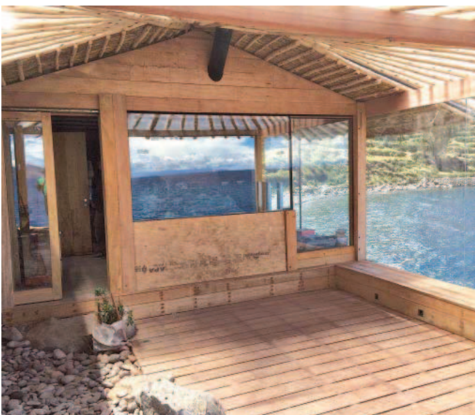
Amantica Lodge se crea a partir de una estructura de madera que se sostiene en pilotes anclados en el terreno. El piso se compone de totora, aserrín y cal, cerrándose con tablones de madera. El muro orientado al norte se compone de adobe. La terraza se protege del exterior a través de un vidrio templado y un techo de policarbonato. El techo de una estructura está forrado con un mix de totora, caucho reciclado y totora. El cerramiento final de totora se repite en los otros espacios como el baño, la cocina y el depósito.
