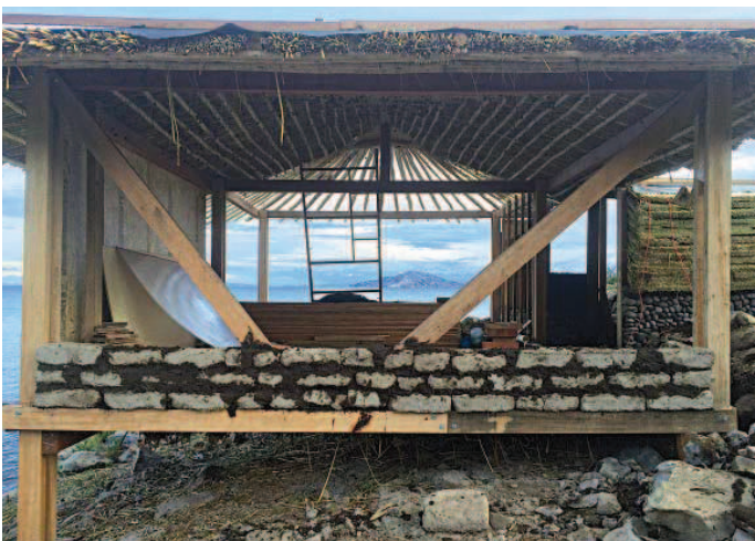
Amantica Lodge se crea a partir de una estructura de madera que se sostiene en pilotes anclados en el terreno. El piso se compone de totora, aserrín y cal, cerrándose con tablones de madera. El muro orientado al norte se compone de adobe. La terraza se protege del exterior a través de un vidrio templado y un techo de policarbonato. El techo de una estructura está forrado con un mix de totora, caucho reciclado y totora. El cerramiento final de totora se repite en los otros espacios como el baño, la cocina y el depósito.
