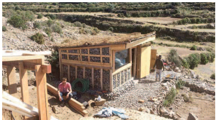
El baño está rodeado de un muro de 60 cm de espesor, construido con una técnica constructiva aymara. Por el otro lado, un muro se compone por rocas apiladas cuidadosamente. En otra de las paredes se colocaron capas de totora que impermeabilizan el espacio. La cocina se construyó a partir de los vidrios colocados en la habitación principal.
